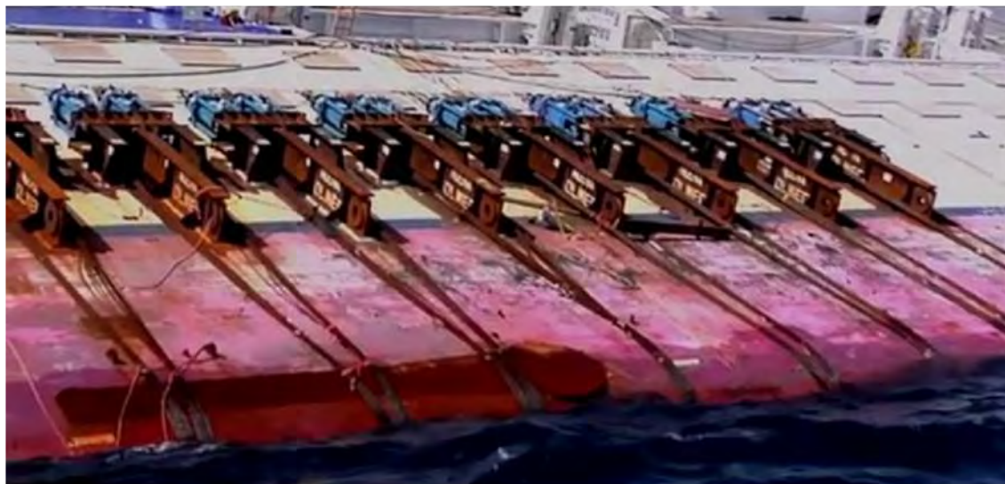
Martinetti idraulici con catene per il raddrizzamento sui lati collegati a terra ed alle parti esterne della piattaforma.
